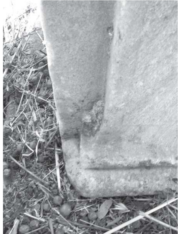
Abb. 104 Profil der Pfeilerrückwand zu ii 45.
