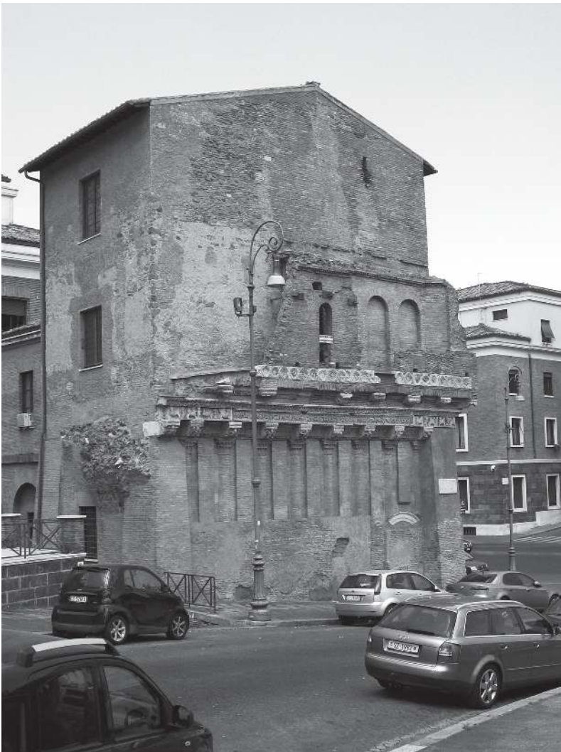
Abb. 124 Casa dei Crescenzi, Rom.
