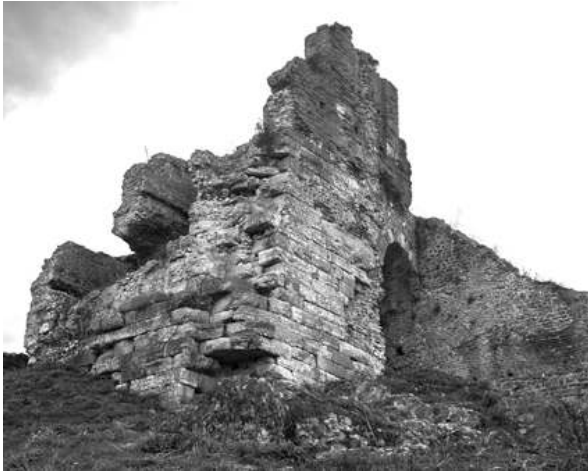
Abb. 50 Nikopolis. Ansicht der östlichen parodos . Blickrichtung Nordwesten.
