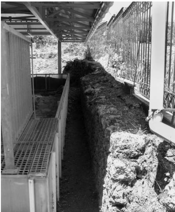
Abb. 88 Skala. Heutiger architektonischer Kontext der Mosaik. Zu sehen sind die umfangreichen Ein- und Abgrenzungsmaßnahmen, die teilweise auf den antiken Mauern errichtet sind.
