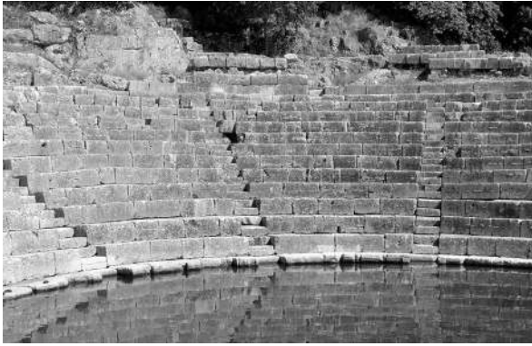
Abb. 31 Butrint. Blick auf die cavea des Theaters.
