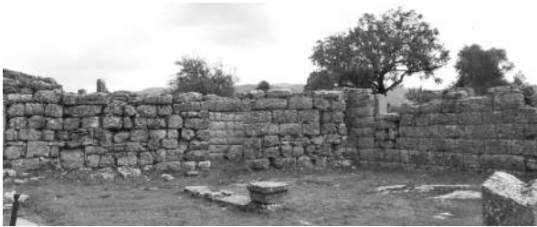
Abb. 35 Dodona. Ansicht des inneren Mauerrings im östlichen Teil des Skenengebäudes. Zustand im Sommer 2005.
