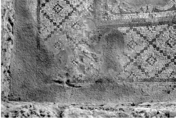
Abb. 87 Skala. Detailansicht einer Raumecke mit fragmentiertem Mosaikboden. Mittig im Bild ist auf dem Mosaik eine runde Standspur zu erkennen.
