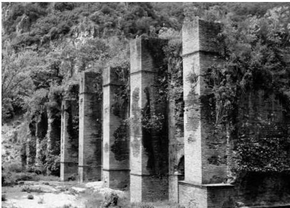
Abb. 69 Nikopolis. Nordseite des als älter geltenden Aquädukts im Louros-Tal bei Agios Giorgos. Die vorderen Pfeiler sind restauriert.
