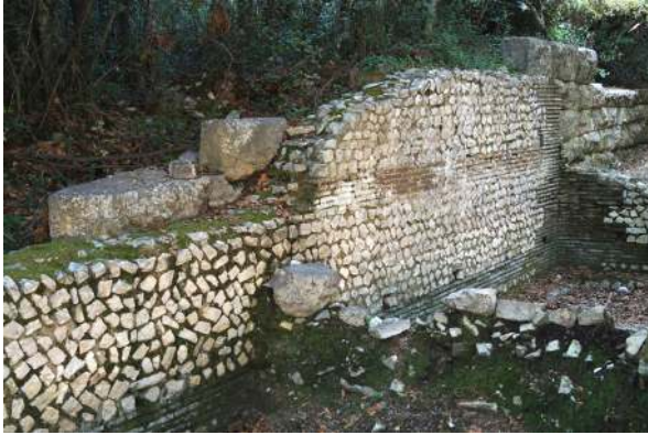
Abb. 62 Butrint. Ansicht des Mauergevierts nördlich der Großen Basilika. Zu sehen sind Teile der mit opus quasi reticulatum mit Ziegeldurchschuss zugesezte hellenistische Stadtmauer aus Quadermauerwerk.
