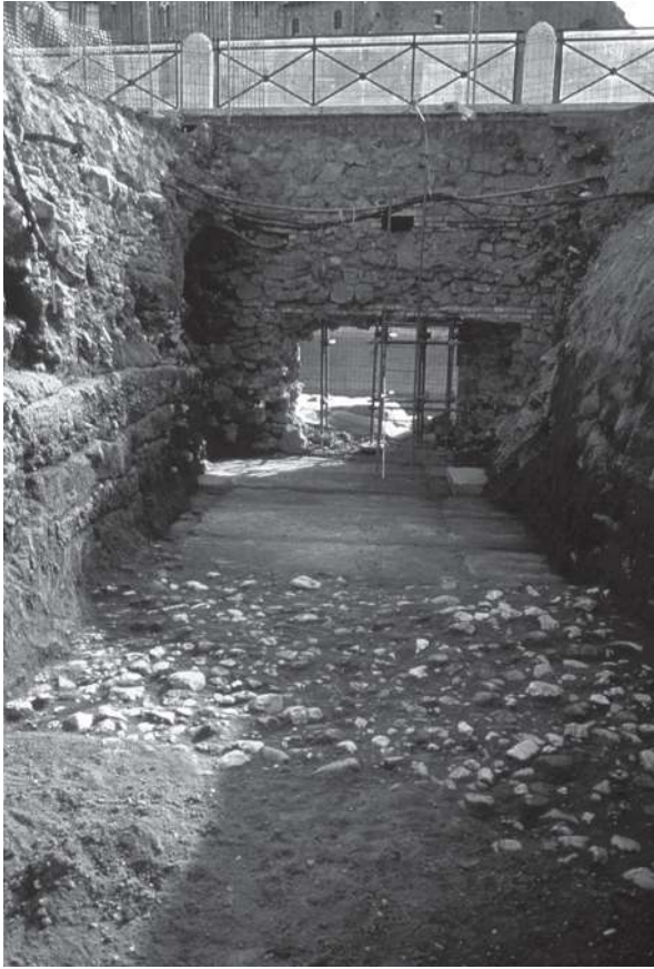
Fig. 5 Foro di Traiano. Restauri del IX secolo in acciottolato del pavimento marmoreo della piazza del Foro.
